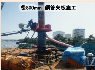
径600mm SqCビ7用鋼管支持杭施工
